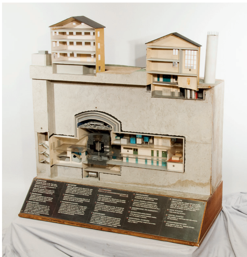
Modell i skala 1:50 av eksperimentreaktoren R1. Modellen ble utarbeidet av AB Atomenergi for å vise omfanget av den underjordiske virksomheten. Modellen viser et tverrsnitt av anlegget med sine maskiner. Foto: Peter Häll, Tekniska museet.
